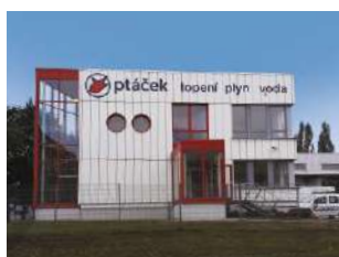
Instalatércentrum Praha 6 - Ruzyně Stochovská 1057/80
