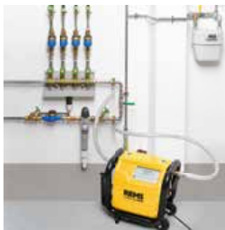
Proplachování rozvodů pitné vody
