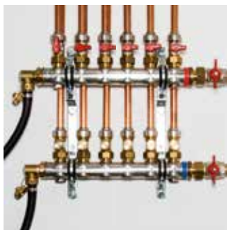
Proplachování radiátorů a plošných topných systémů
