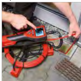
Inspekce potrubí pro svod dešťové vody
