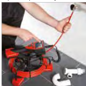
Inspekce odpadů a umyvadel
