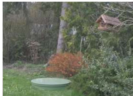
ČOV TOPAS S 5 po instalaci
